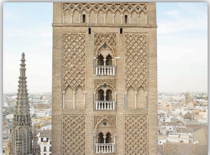
Detalle de estructura. Foto: A. Carnicero
